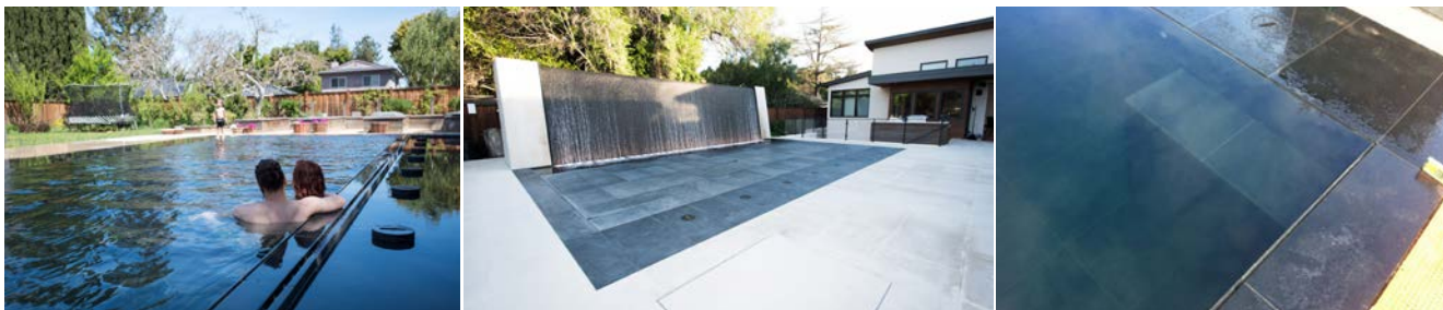
Ein Schwimmbecken mit vielen Show-Elementen. Dank des Hubbodens kann die Fläche mehrfach, zum Beispiel als Party-Location, genutzt werden.
